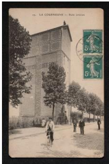
8Fi081 : vue du château d'eau avant sa transformation en logements
